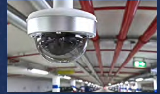
v26 Indoor Dome
